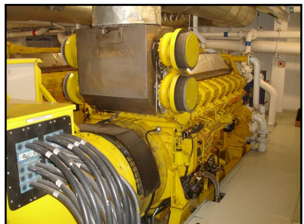
Abb.: 2. Das Schiff besitzt außerdem zwei Hilfsmotoren, die mit Marinedieselöl (MGO, Abk. für Marine Gas Oil) betrieben werden und die die Elektrizität für das Schiff liefern, siehe
